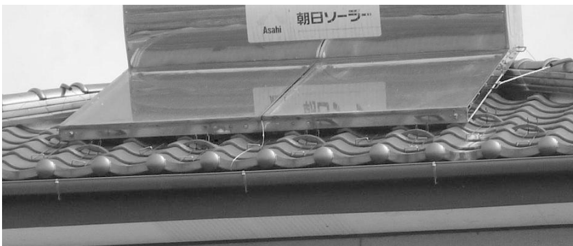
三州瓦屋根の施工事例
