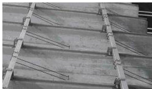
写真右：未施工の折板屋根
